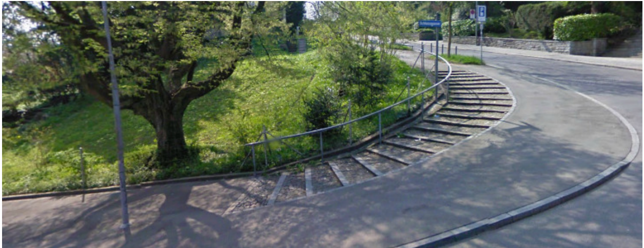
Treppe und Rampe. Wiedingstr./Schloßgasse, 8003 Zürich
